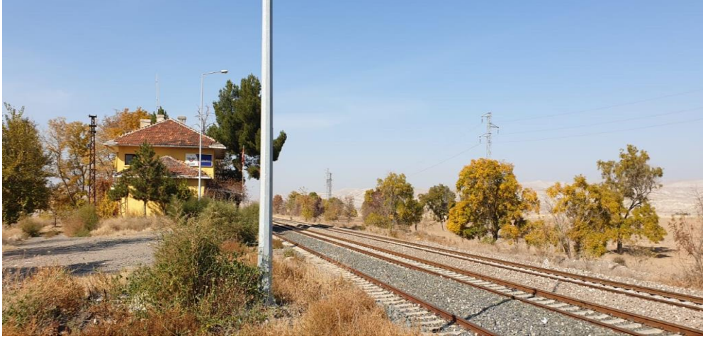
Resim1. Germece Tren İstasyonu Şefliđi
