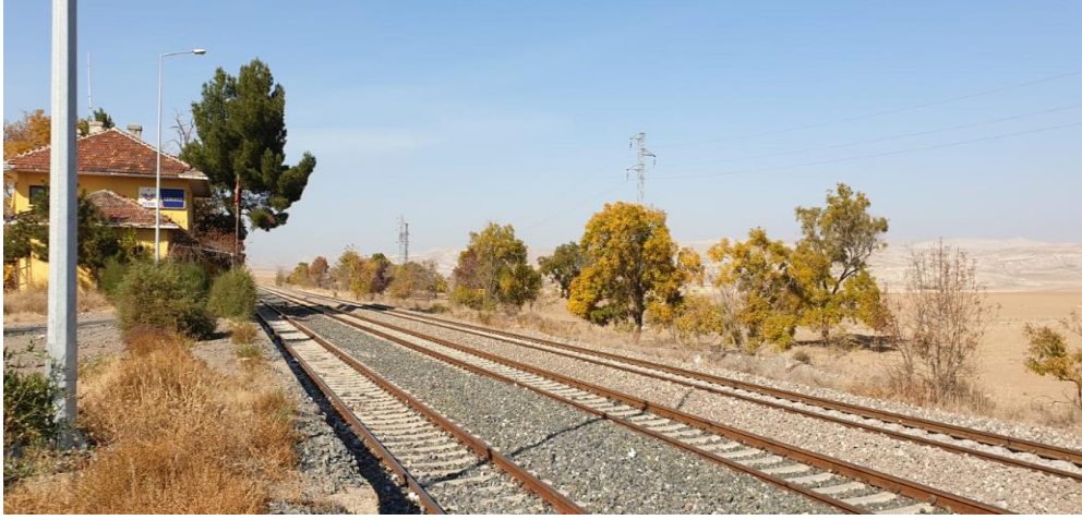
Resim2. Germece Tren İstasyonu Şefliđi
