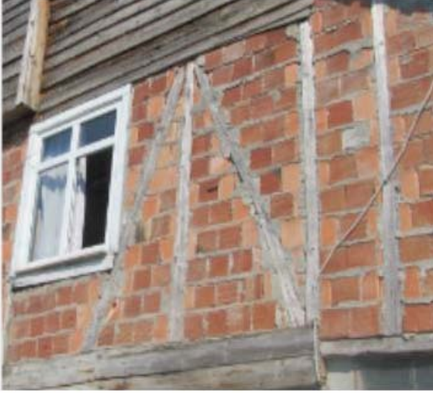
Ahşap karkas yapım sistemi
