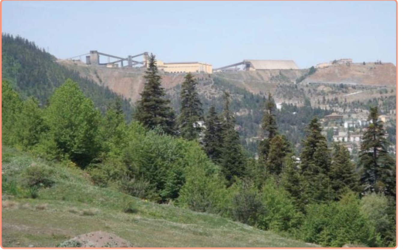
■ Maden sahasındaki zenginleştirme tesisi
