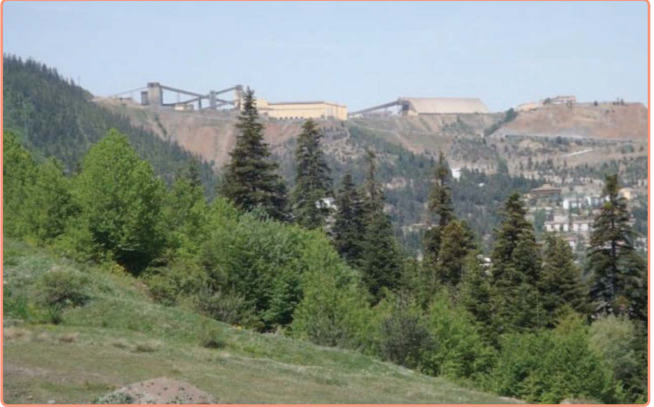
■ Maden sahasındaki zenginleştirme tesisi
