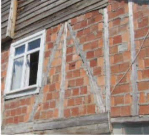
Ahşap karkas yapım sistemi
