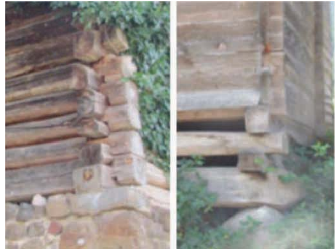
Ahşap yığma yapım sistemi
