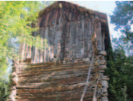
Fotoğraf 36: Karış Mahallesi - Parsel:7
