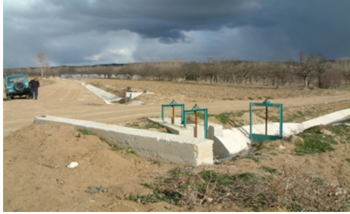
Fotoğraf 2. Betondan Yapılmış Klasik Sistem Açık Kanal
