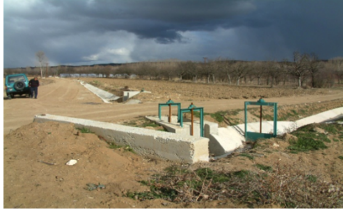
Fotoğraf 2. Betondan Yapılmış Klasik Sistem Açık Kanal
