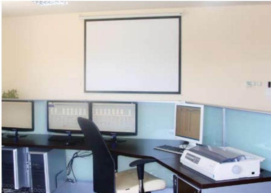
Ankara Sincan OSB Elektrik Kontrol Merkezi
